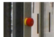
دکمه توقف اضطراری: در مواقع خطر با قطع برق، درب را سریعاً متوقف می کند و امکان عملکرد دستی در قابل استفاده است.
